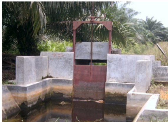
Gambar 13 . Pintu Kanal Permanen
